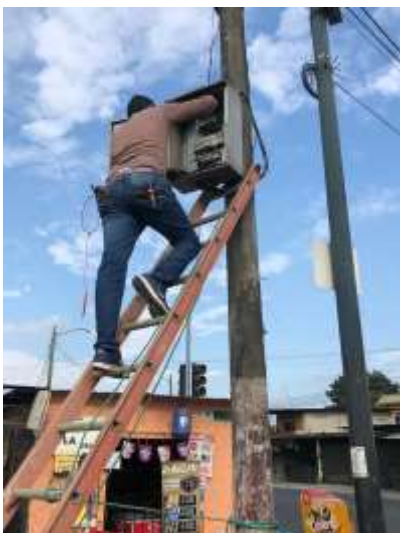
Anexo 2. Mantenimiento preventivo y correctivo de semáforos en la parroquia La Esperanza, vía a San Carlos y vía a Valencia y en la Av. Guayaquil.
