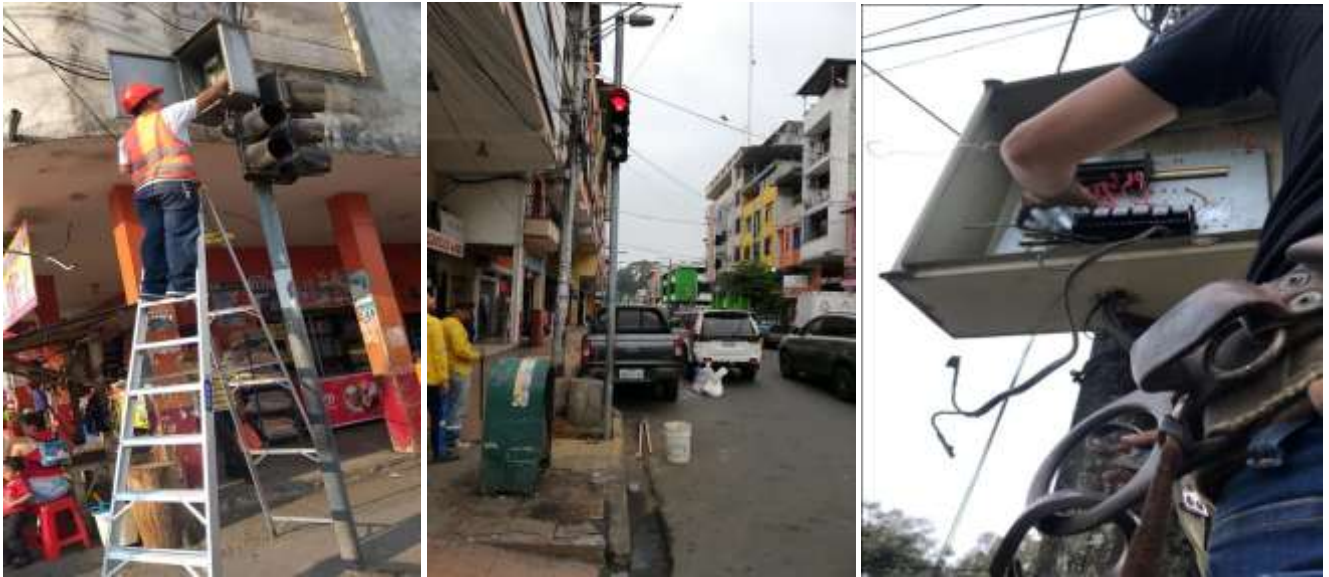
Anexo 3. Mantenimiento preventivo y correctivo de dispositivos semafóricos en la Av. Walter Andrade, Av. Quito, Calle Bolívar, vía a el Empalme y parroquia San Carlos.
